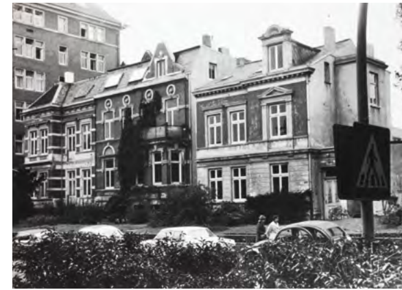
Hier soll 1989 die „Banane“ entstehen – der neue Haupteingang. Drei Häuser kurz vor dem Abriss, 1972
