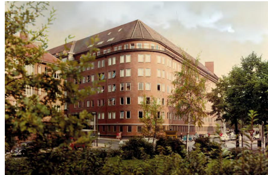
Die für Werk 1 charakteristische runde Ecke fügt sich harmonisch in den Baubestand ein, 1960er-Jahre
