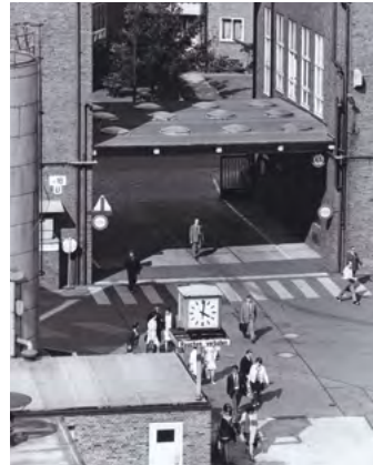
Schicht-Ende! Blick vom Innenhof auf die Quickbornstraße, 1968
