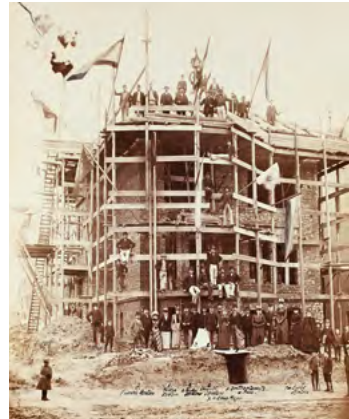
Unser Start in Eimsbüttel: Richtfest Wohnhaus Troplowitz, 1892
